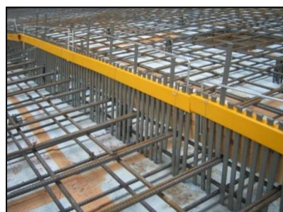
栈木にスラブフェンス極を結束線で固定
